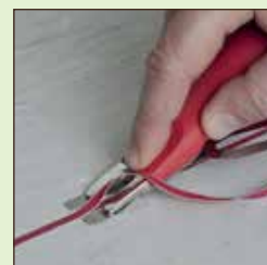
Livellamento finale senza guida
