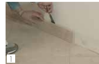
1 Eliminare il battiscopa Remove skirting
