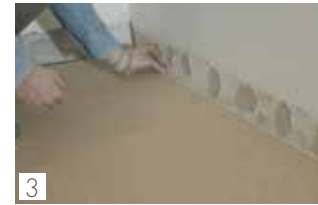
3 Posizionare i distanziali lungo il perimetro Fit the spacers around the outer edge
