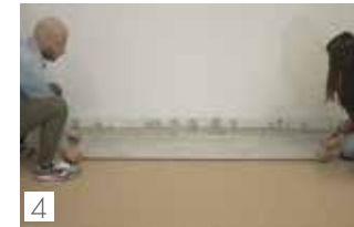
4 Posare il pavimento senza fuga Lay the floor tiles with close joints
