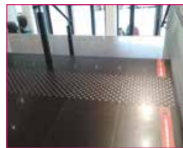
Posa su pavimenti piastrellati
